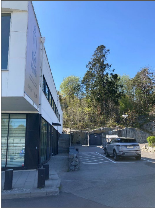
Figur 11. Lomarhusets norra fasad med en av dess entréer med skärmtak. I mitten av fotografiet, inkilad mot berget, syns den grå transformatorstationen.
